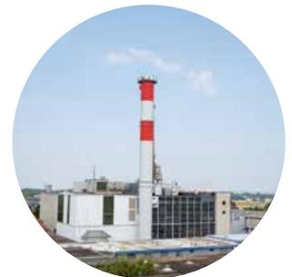
Das Heizkraftwerk des Universitätsklinikums nutzt seit 2011 Holzpellets statt Kohle für die Wärme- und Kälteproduktion und konnte so den CO<sub>2</sub>-Ausstoß um rund 50.000 Tonnen jährlich reduzieren. Weitere 4.000 Tonnen sparen seit 2018 zwei neue Wärmespeicher und ein Kältespeicher ein. Ein neuer Hochdruckdampfkessel ermöglicht demnächst weitere Effizienzgewinne und Emissionsreduzierungen.
