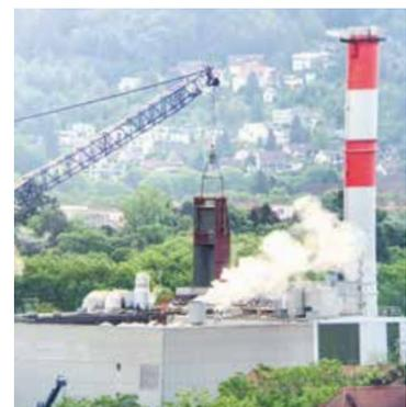
Ein Kran hob Ende Mai die Einzelteile des neuen Hochdruckkessels in das Heizkraftwerk der Uniklinik.
