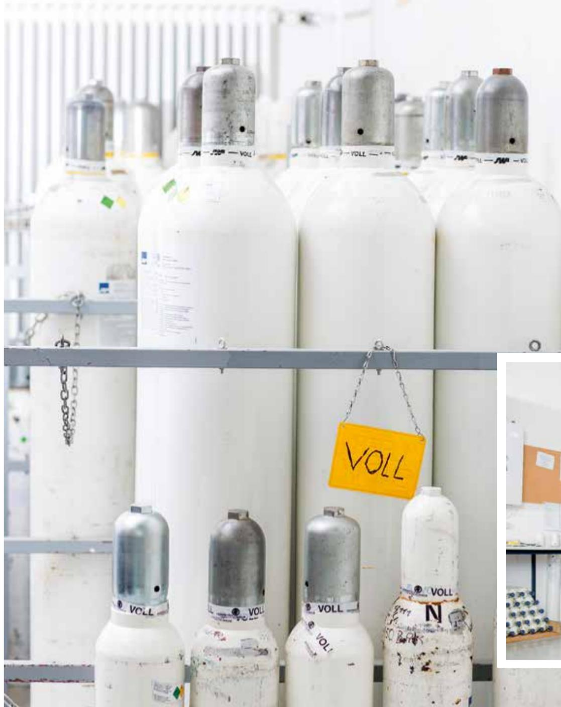
Diese Flaschen werden in Notfällen für die Sauerstoffhauptversorgung angeschlossen
