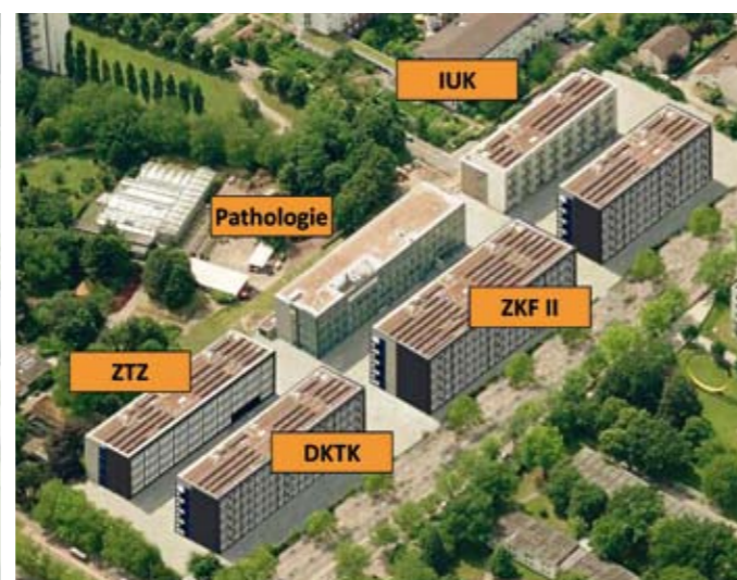
Die neue Institutsspanne an der Breisacher Straße Quelle: Vermögen und Bau Baden-Württemberg
