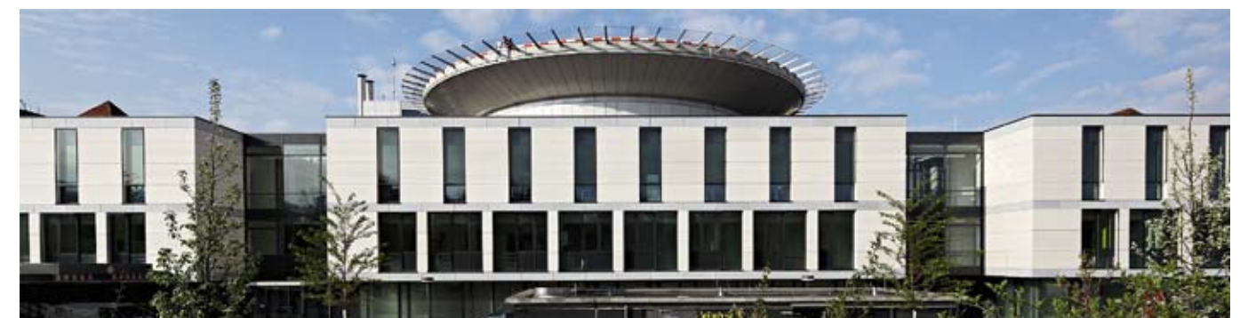
Das Universitäts-Notfallzentrum ist fertiggestellt. Reinhold Keil hat sich zum Ziel gesetzt, weitere Bauprojekte des Masterplans schnell voranzutreiben
