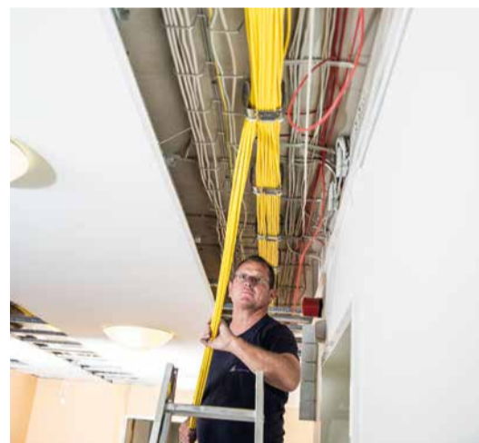
Umbauarbeiten: Allein 2,2 Kilometer EDV-Kabel wurden in der Klinik verlegt.
