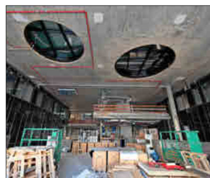
Überall Licht, auch in der verglasten Eingangshalle (oben).
